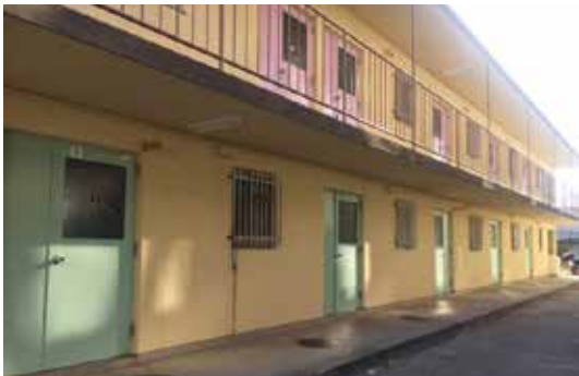
改装工事後の現在のクラブ棟
